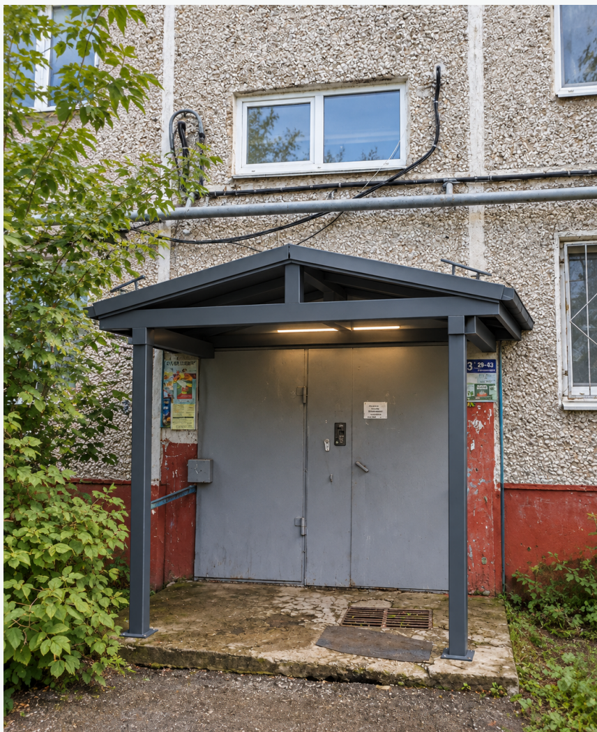
ПРЕДВАРИТЕЛЬНЫЙ ЭСКИЗ · ДВЕ СТОЙКИ · ГЛУБИНА ПО ПЛИТЕ
